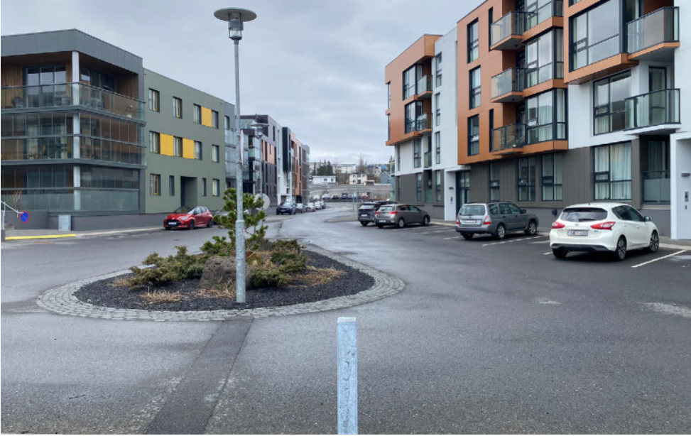
Nýleg íbúðarbyggð hefur breytt umhverfi svæðisins og karakter.
