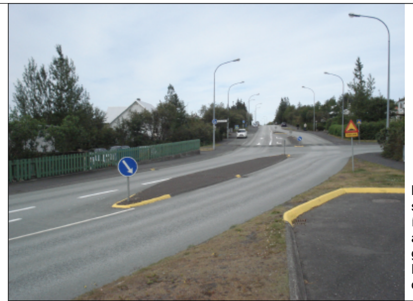
koddi verður settur niður í miðja akrein austan við gatnamót Digranesvegur og Bröttubrekku
