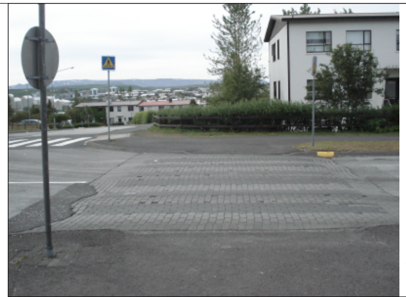
gangbraut og upphækkun við Digranesveg 36 verða endurnýjuð
